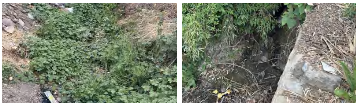
图 3-2 刘老庄黑臭水体现状照片
