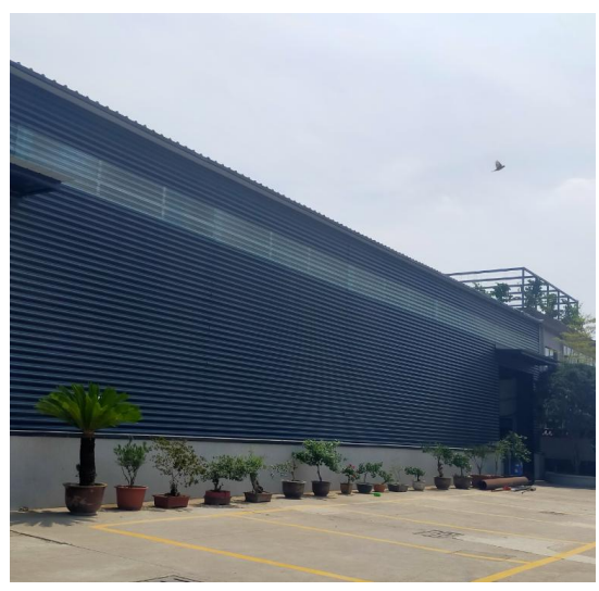
项目生产车间
